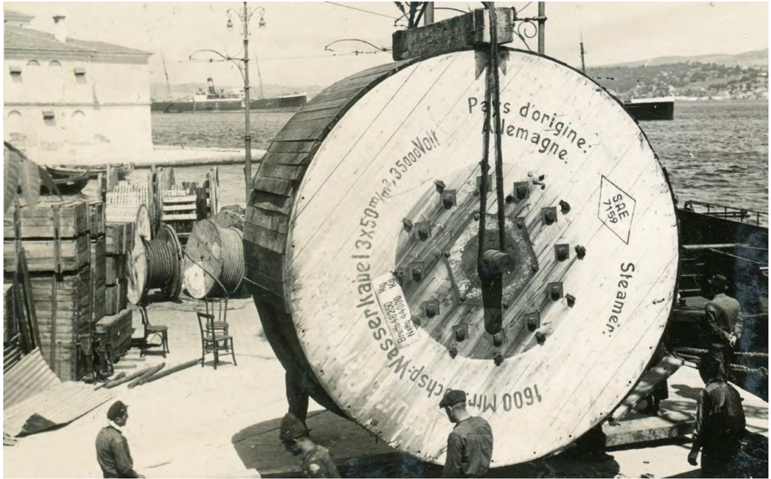
Şekil 20.5 50 tonluk makaranın askıya alınması. Silahtarağa Arşiv.
