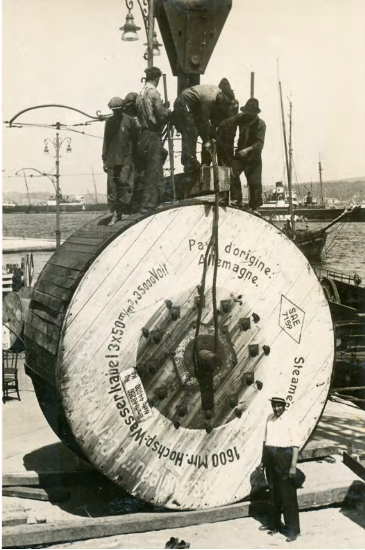
Şekil 20.6 50 tonluk makaranın askıya alınması. Silahtarağa Arşiv. Figure 20.6 Raising the 50 ton cable drum. Silahtarağa Archive.
