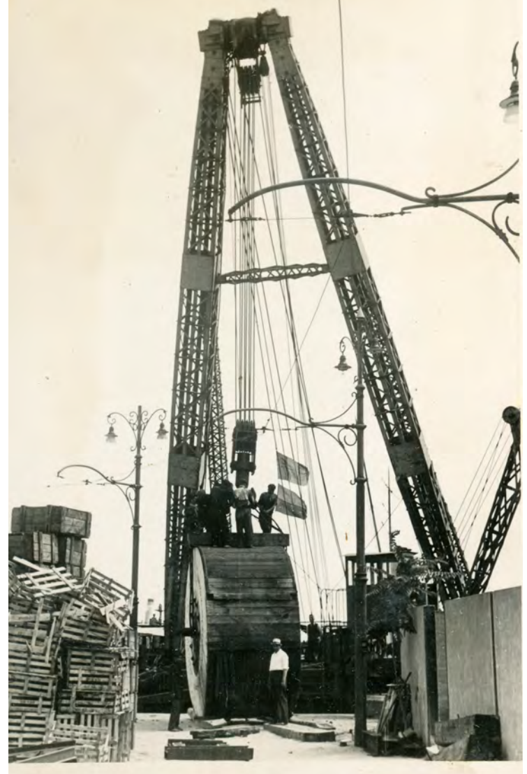
Şekil 20.7 50 tonluk makaranın askıya alınması. Silahtarağa Arşiv. Figure 20.7 Raising the 50 ton cable drum. Silahtarağa Archive.
