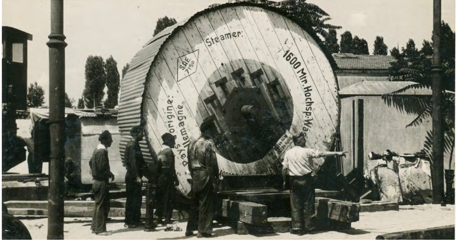
Şekil 20.4 35 kilovatlık deniz kablosu 50 tonluk makaranın vinçle kaldırılmak üzere hazırlanması. Silahtarağa Arşiv.
